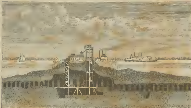
Fig. 1. La galería subterránea de la Roca Flood, abierta para preparar la explosion.—AA. Línea de nivel de las aguas bajas
